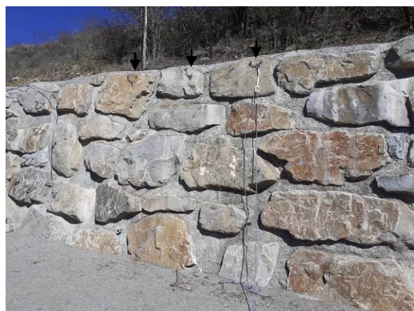
Trois voies d'initiation à l'escalade Viennent compléter le mur d'escalade situé à l'intérieur du bâtiment.
